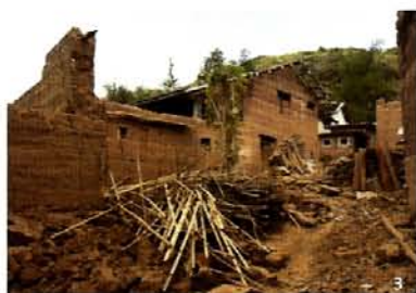
1. 村民涉水过河 2. 年迈的孟大爷夫妇 3. 倒塌的夯土墙以及被视做“垃圾”的材料
