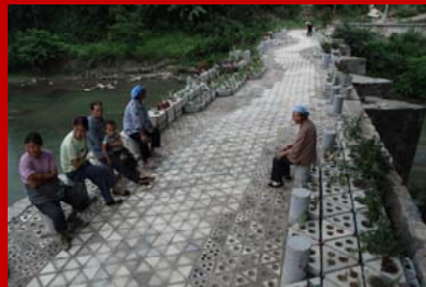
位於貴州新場村的銘昌無止橋
