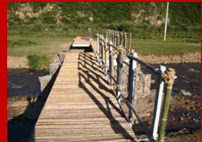
位於甘肅少地村的無止橋
