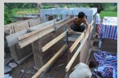
夯土牆抗震測試
