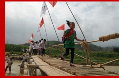
位於甘肅太白村的新世界無止橋
