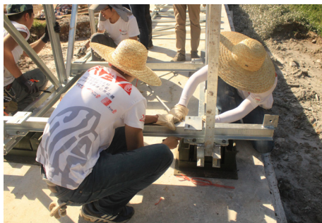
图6.3.8 安装抗风拉杆
