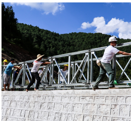
图6.3.10 无止贝雷桥顶推过程
