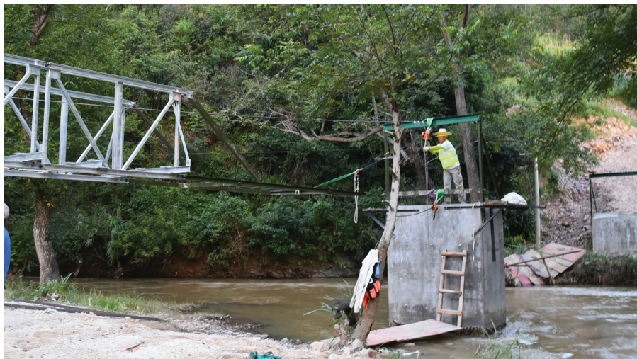
图6.3.11 在中间桥墩利于进行牵引
