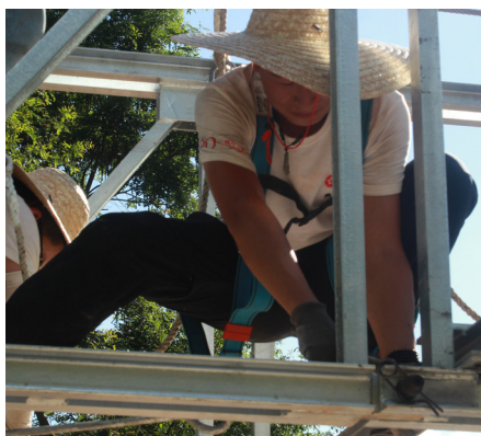
图6.3.13 螺栓检查
