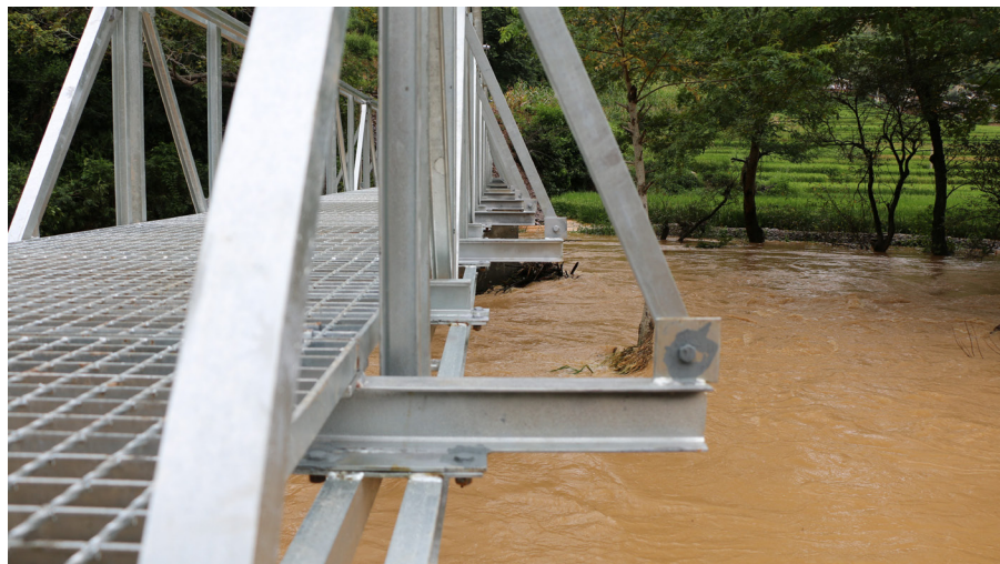
图6.2.3 安装后的斜撑
