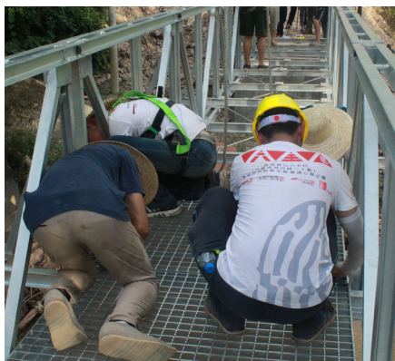
图6.3.12 安装桥面板
