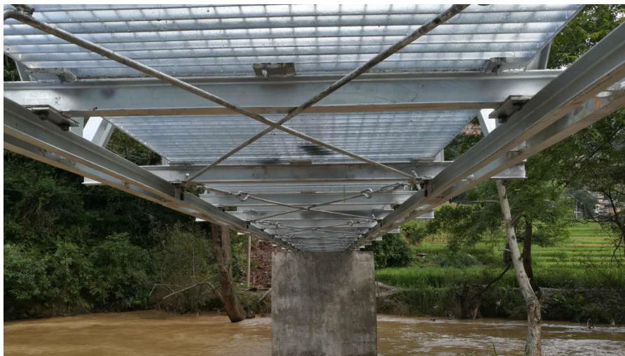
图6.2.4 安装后的抗风拉杆
