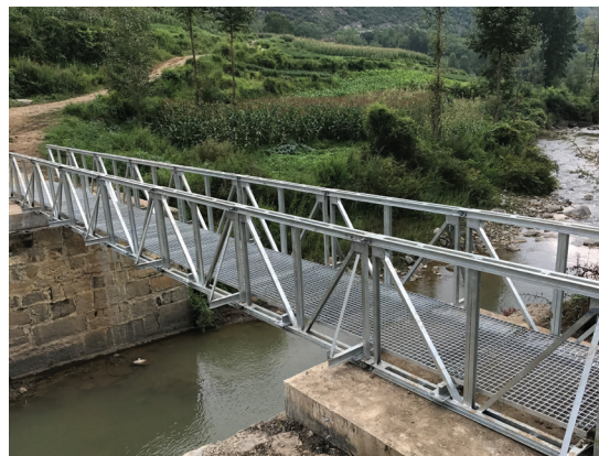
图4.1.4 无止贝雷桥实物图
