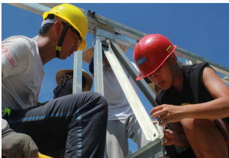
图6.3.7 安装斜撑
