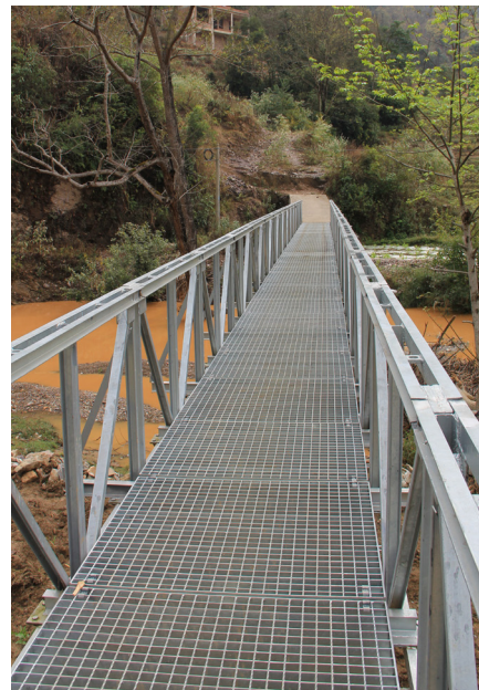
图6.2.6 安装后的格栅板
