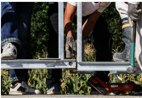
图6.3.3 阴阳头节点对接
